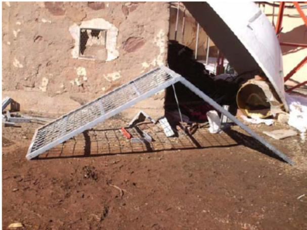
Un abri métallique en caillebotis adapté au diamètre de l'antenne et à la fixation du pylône ou support d'antenne, cette fixation doit être robuste afin de supporter le poids de la neige et l'effet de vent,
